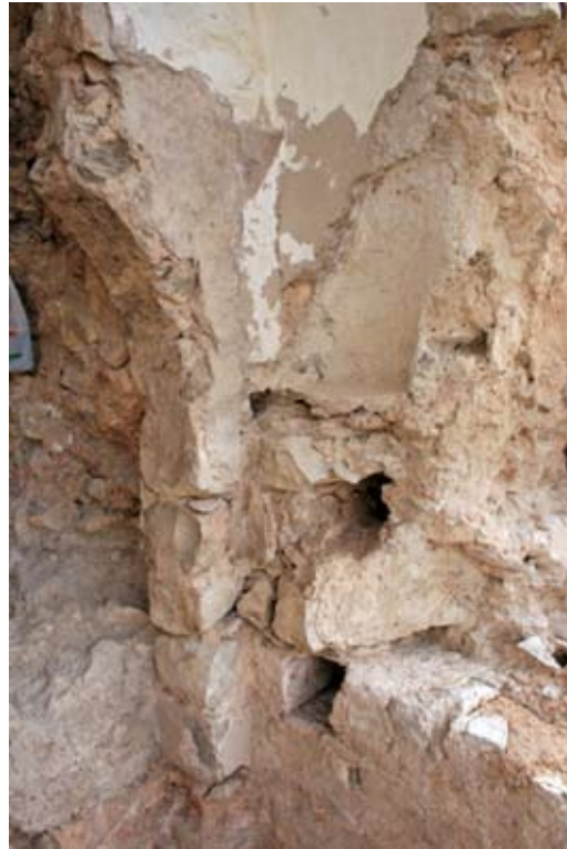
Detalle del sistema de cierre de la puerta del castillo.
