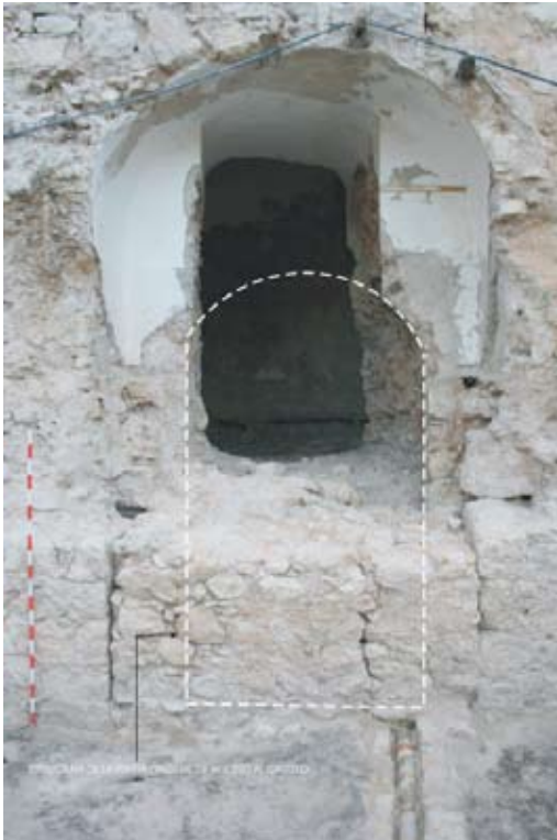
Detalle del acceso original al castillo en 1415.
