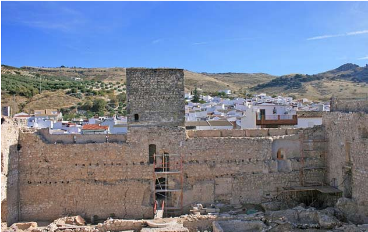
Vista del paramento interior de la muralla este y torre del homenaje.
