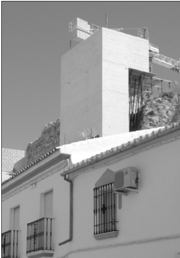
Torre Noroeste en proceso de ejecución.
