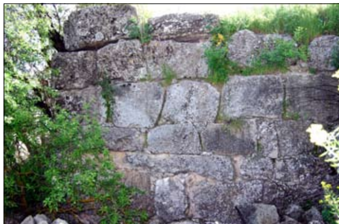
Detalle del paramento de la torre norte.
