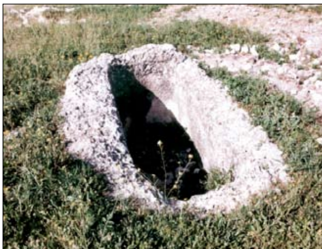
Cisterna de planta ovalada realizada en opus caementicium para almacenar agua.
