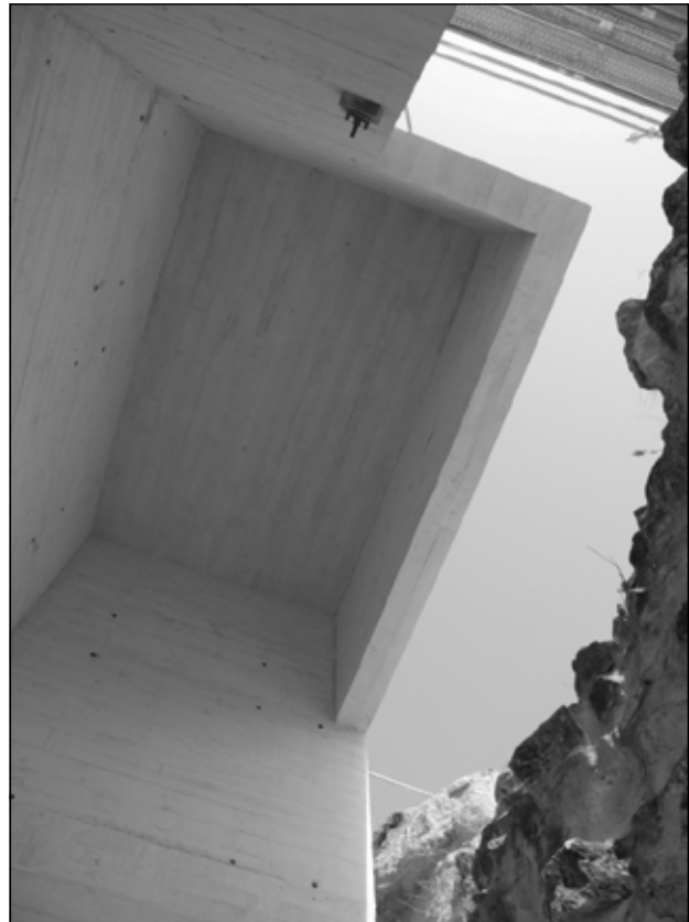
Vista interior de la estructura de hormigón.
