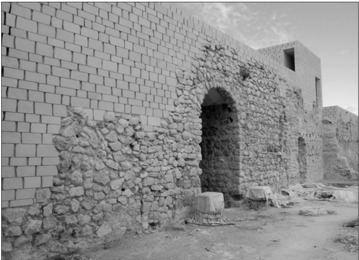
a: Restitución volumétrica de Torre Oeste; b: Contacto entre fábrica de nueva ejecución y estructuras históricas.
