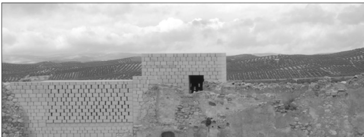
a-b: Fase de ejecución y estado final del la cubiertas flotantes de losas de piedra c: Torre Oeste d: Torre Norte.
