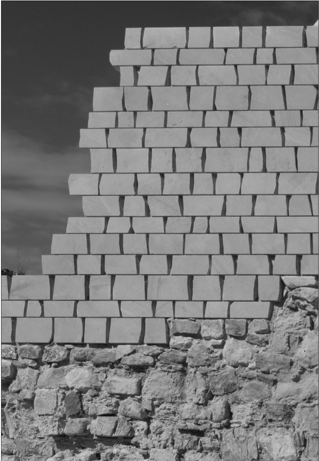
Contacto entre las fábricas de piedra de nueva ejecución y los restos de estructuras históricas.
