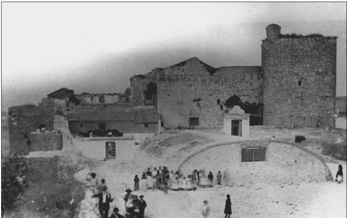
Torre de las Arquerías desde la calle Llano de Santa María. Foto: Carmelo Ruiz.
