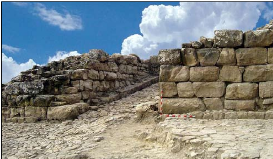
Vista de la Puerta Oriental antes de las labores de restauración y puesta en valor.
