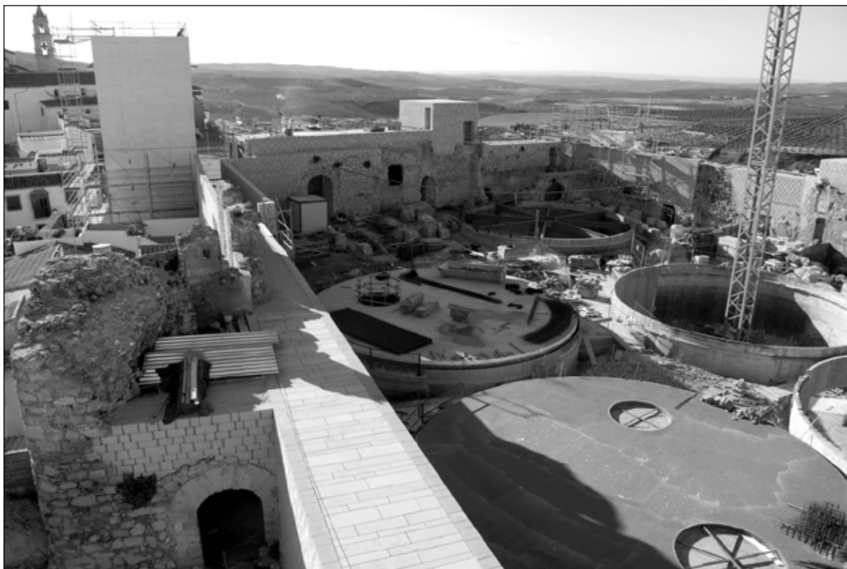
Vista general del patio de armas durante la fase de cubrición de los depósitos de agua.
