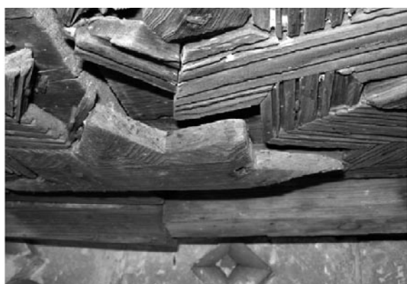
Detalles de los daños del taujel: suciedad, humedad y desensamble de piezas
