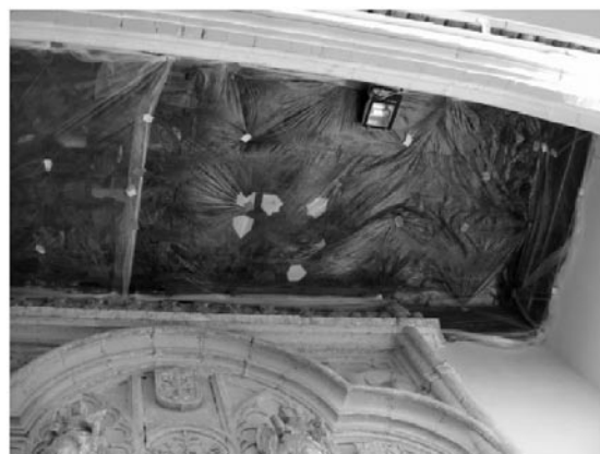
Detalles de la intervención: limpieza, reposición de piezas y aplicación de desinsectante.
