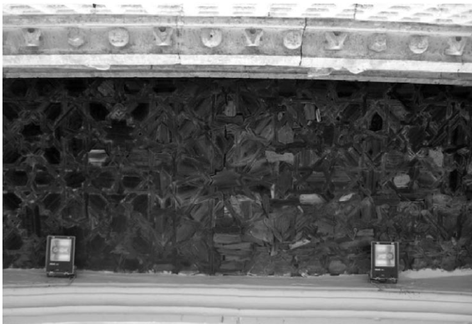
Imagen del taujel antes de las obras de restauración.
